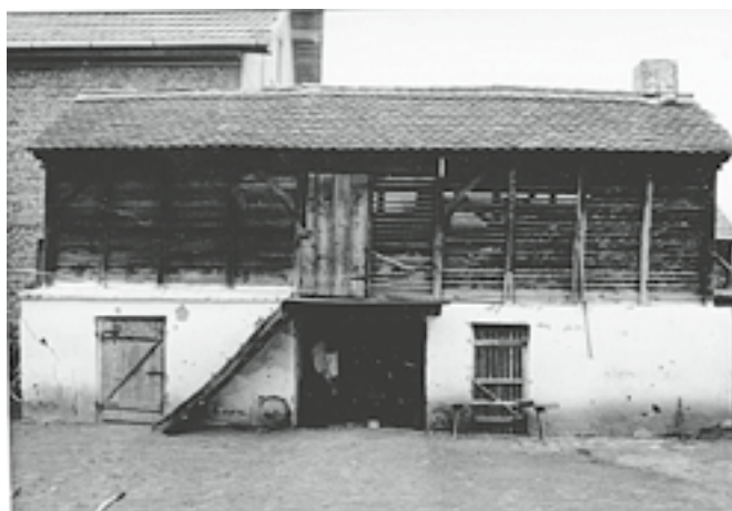
Фото. 11 Амбар, ул.Жарка Зрењанина бр.35
